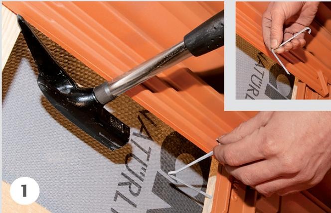
Die Einschlagklammer ist für alle auf dem Dach geforderten Lattenquerschnitte geeignet.
