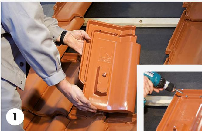
Das Alu-Grundelement wird in die Dachfläche eingedeckt und mit zwei korrosionsbeständigen Schrauben an der Traglattung befestigt. Die zusätzliche Montage einer Stützlatte ist nicht erforderlich. Der Stützabstand sollte bei Schneefangsystemen max. 80 cm betragen. Je nach Schneelastzone muss der Stützabstand verringert werden. Eventuell sind zwei Schneefangsysteme zu montieren.
