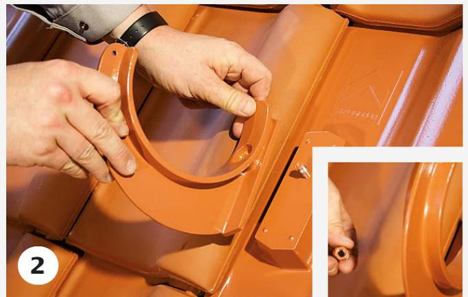
Der Rundholzhalter wird auf das Alu-Grundelement aufgesetzt und mit der gelieferten Schraube befestigt. Hierzu verwendet man einen 13er Schraubenschlüssel.
