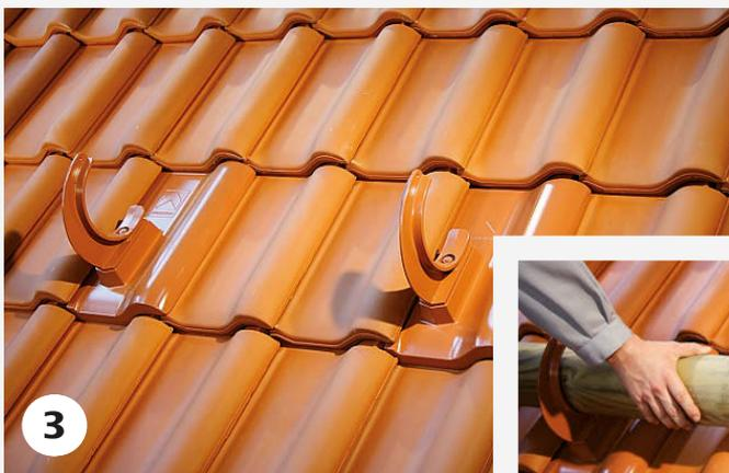
Das Rundholz wird in die Rundholzhalter eingelegt und nach rechts und links ausgerichtet. Der Durchmesser des Rundholzes sollte max. 14 cm betragen.
