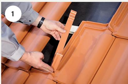
Die Schneenasen sollten direkt bei der Verlegung der Dachziegel mit verarbeitet werden.
