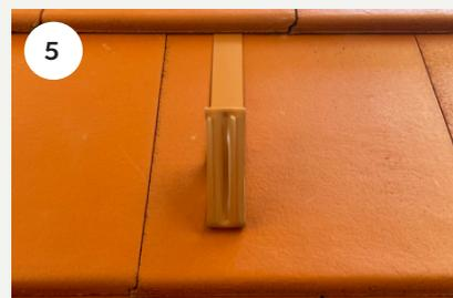
Beim Dachstein Kapstadt ist die Positionierung analog Abbildung 5 außermittig vorzunehmen.
