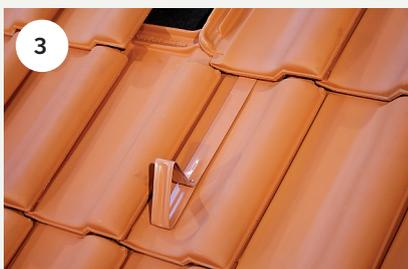
Der darüberliegende Dachziegel wird ebenfalls in die Dachfläche eingedeckt, so dass die Schneenasen fest in der Kopfverfaltung eingedeckt ist.
