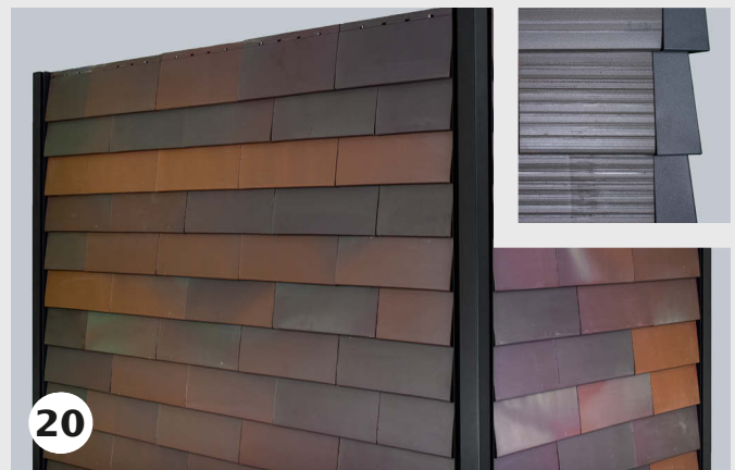
20 Fertigstellung der Eindeckung. Im Anschluss muss der Kopfpunkt (Attika) berücksichtigt und mit einer Blecheindeckung regeneintragsicher verblendet werden. Alternativ können auch Eckprofile für jeden Ziegel angefertigt werden (siehe Detailbild).
