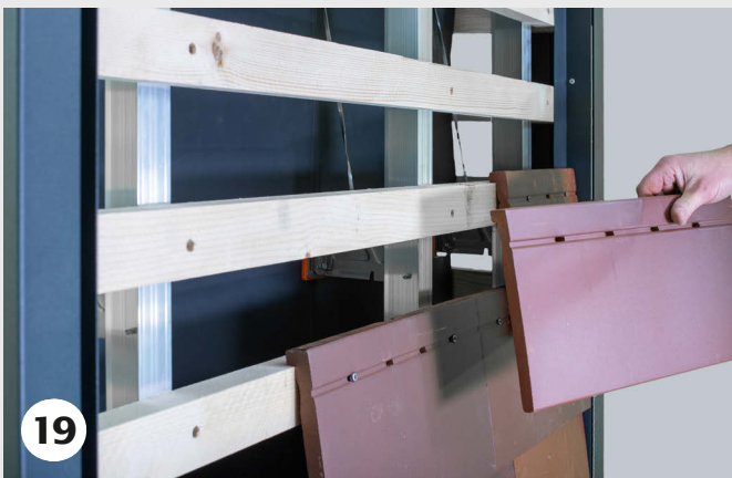
19 Eindecken der MOTIO-Ziegel von unten nach oben im Halbverband. Eine Fugenverschiebung von mindestens 10 cm muss gewährleistet werden.
