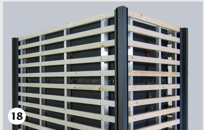
18 Anbringen der Eckprofile und gegebenenfalls Laibungsbleche für Türen und Fenster.
