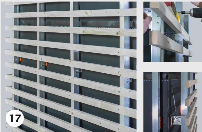
17 Anschrauben der Traglatten aus Holz 30 x 50 mm oder 40 x 60 mm an die vertikalen Metallschienen. ⚠ Tipp: Auf die richtige Schraubenlänge und das Ausrichten mit der Wasserwaage ist zu achten.
