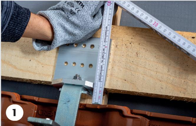
Solarhalter auf dem Holzbrett positionieren und den Abstand von Oberkante Ziegel/Dachstein bis zum Schraubenkopf (der Fixierung von Haken und Grundplatte) mit ca. 5 mm Luft einhalten (Ziegelbruch bei Nichtbeachtung). Daraus resultiert ein Abstand von Oberkante Ziegel/Stein zur Unterkante Brett von ca. 3 cm.
