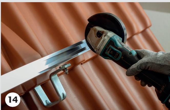
14 Nach der Verschraubung der Haken kann damit begonnen werden, die Schienen anzupassen und gegebenenfalls mit einer Eisensäge oder einem Winkelschleifer abzulängen.
