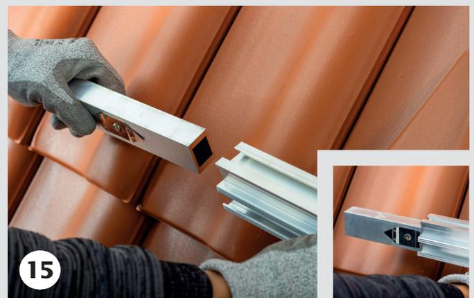
15 Eine Schienenverlängerung und ein Aneinanderreihen von Schienen ist mittels Schienenverbinder durchzuführen.
