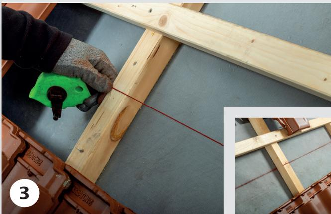
Die angezeichnete Positionierung des Holzbretts mittels Schnurschlag auf das Dach übertragen.
