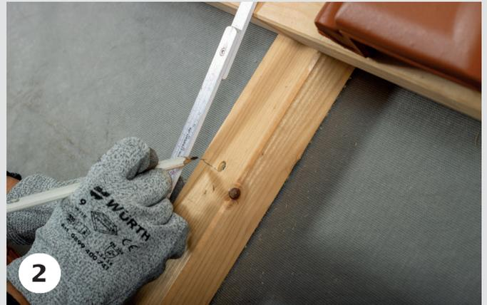
Die Oberkante des Holzbretts entsprechend dem Verlegeplan und der Dacheinteilung anzeichnen.
