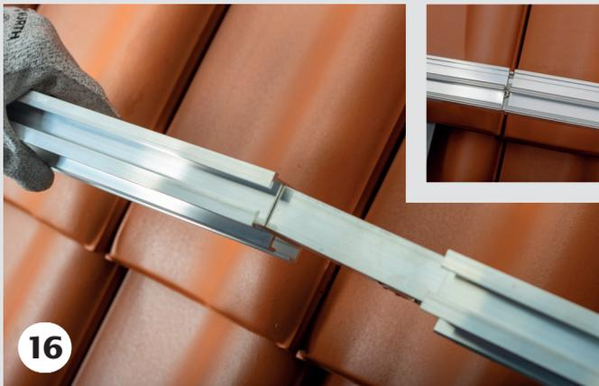
Der Stoß sollte nicht geschlossen ausgeführt werden (siehe Detailbild), sondern für eine thermische Längenveränderung leicht geöffnet bleiben. Die Verbinder so positionieren, dass diese zwischen zwei Solarhalter liegen.
