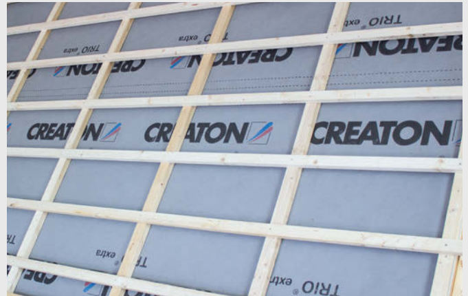
Das regensichere Unterdach in finaler Ausführung. Weitere Informationen unter www.creaton.de .
