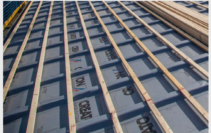
Das wasserdichte Unterdach in finaler Ausführung. Weitere Informationen unter www.creaton.de .
