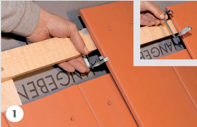
Die Biberklammer wird zur Fachregelgerechten und nach EN 14437 geprüften Sturmsicherung für Steildächer verwendet.
