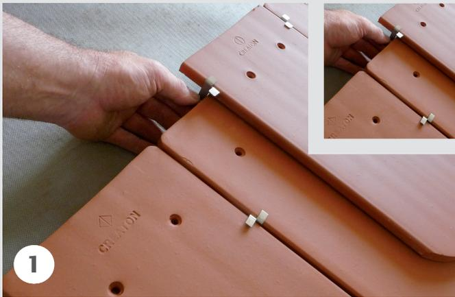
Die Kronendeckungsklammer verbindet die Deckschicht mit der Lagerschicht und wird besonders für Gebäude in exponierter Lage eingesetzt.
