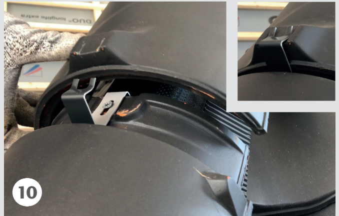
10 Den nächsten Firstziegel/-stein anfügen und in die Firstklammer einschieben.
