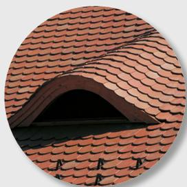
Detaillösungen wie Kehlen, Gauben und Grate können dadurch harmonisch ausgeführt werden
