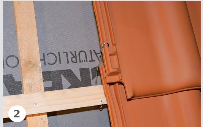
Die Einhängeklammer wird mit dem langen, nach oben stehenden Schenkel in die Seitenverfaltung des rechts oben liegenden CREATON Tondachziegels befestigt. Der Tondachziegel links unten ist bei dieser Darstellung nicht abgebildet, sollte aber zuvor eingedeckt werden.
