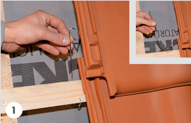
Die Einhängeklammer wird meist magaziniert auf Kunststoffstreifen mit je 25 Klammern geliefert und ermöglicht so eine schnelle Entnahme aus der Verpackung.
