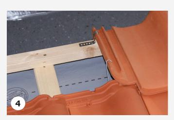
Jeder weitere Pultziegel wird am Pultabschluss eingedeckt und mit einer Sturmklammer und der zusätzlichen Schraubklammer für Pultziegel befestigt.
