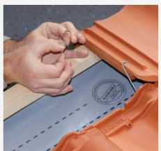
Die Schraubklammer für Pultziegel wird per Hand oder mit einer Zange an der Markierung umgebogen und in die richtige Position
