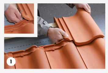
Der rechte Pult-Ortgangziegel wird am Pultabschluss eingedeckt und mit einer für den jeweiligen Dachziegel geeigneten Sturmklammer an der Traglattung des darunterliegenden Ziegels befestigt.
