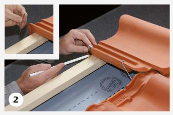
Die Schraubklammer für Pultziegel wird in die Verfalzung des Ziegels eingelegt und die benötigte Länge an der Oberkante der letzten Traglattung angezeichnet.
