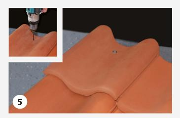
Der linke Pult-Ortgangziegel wird ebenfalls eingedeckt. Mit einem 6 mm Steinbohrer wird im Bereich der darunterliegenden Traglattung ein Loch in den Pult-Ortgangziegel gebohrt. Die eigentliche Befestigung erfolgt dann über eine korrosionsbeständige Spenglerschraube, Durchmesser mind. 4,5 mm, bei einer Einschraubtiefe von mind. 24 mm ins Nadelholz.
